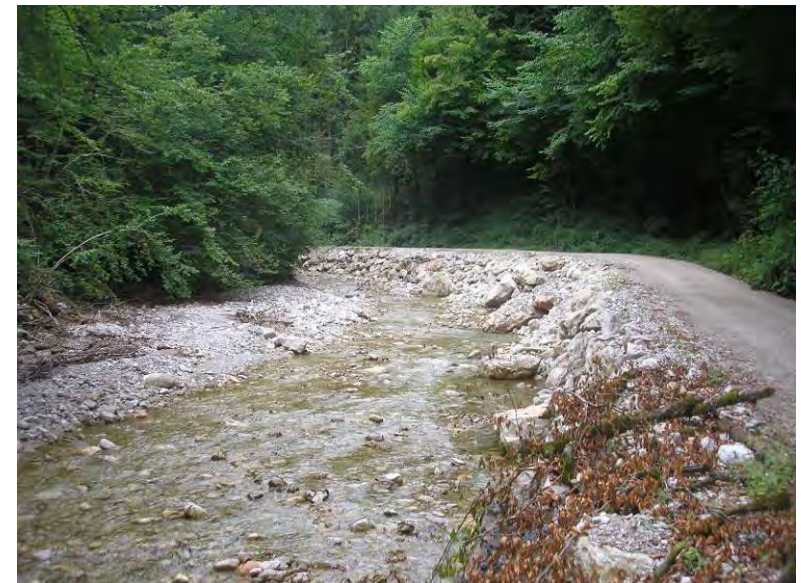
Foto 2: Steinschlichtung, Blick flussaufwärts
