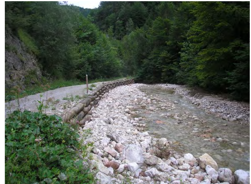
Foto 4: Uferbefestigung durch Holzverbauung, eingebaggertes Bachbett, Blick flussabwärts
