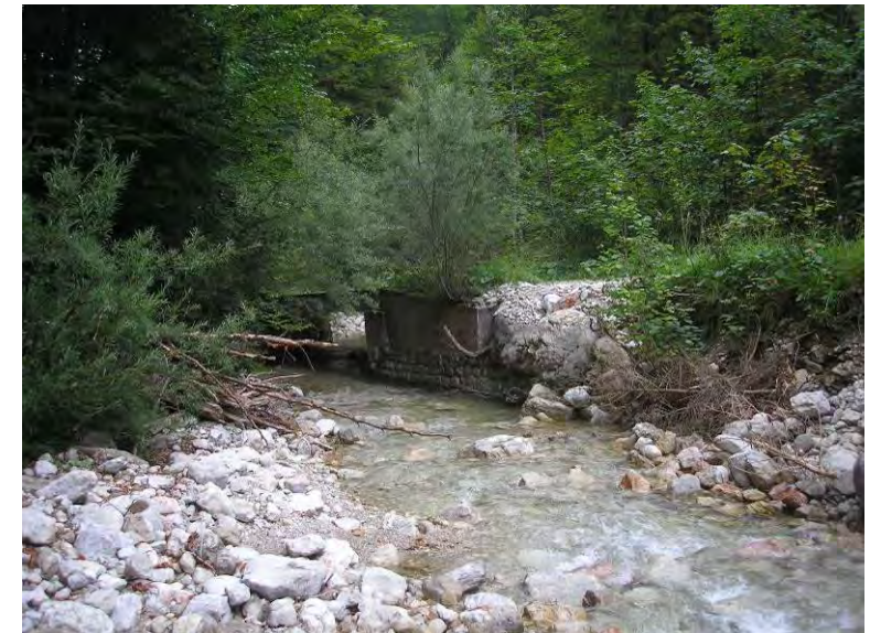
Foto 6: Brücke mit massiver Befestigung durch Mauer und Steinschlichtung, Blick flussabwärts
