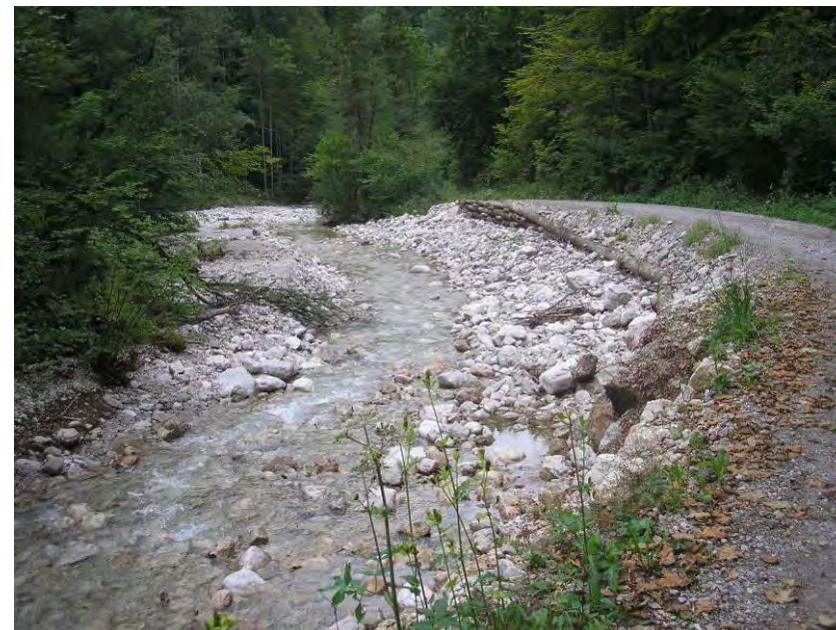
Foto 3: Uferbefestigung mit Blockverbauung, Blick flussaufwärts
