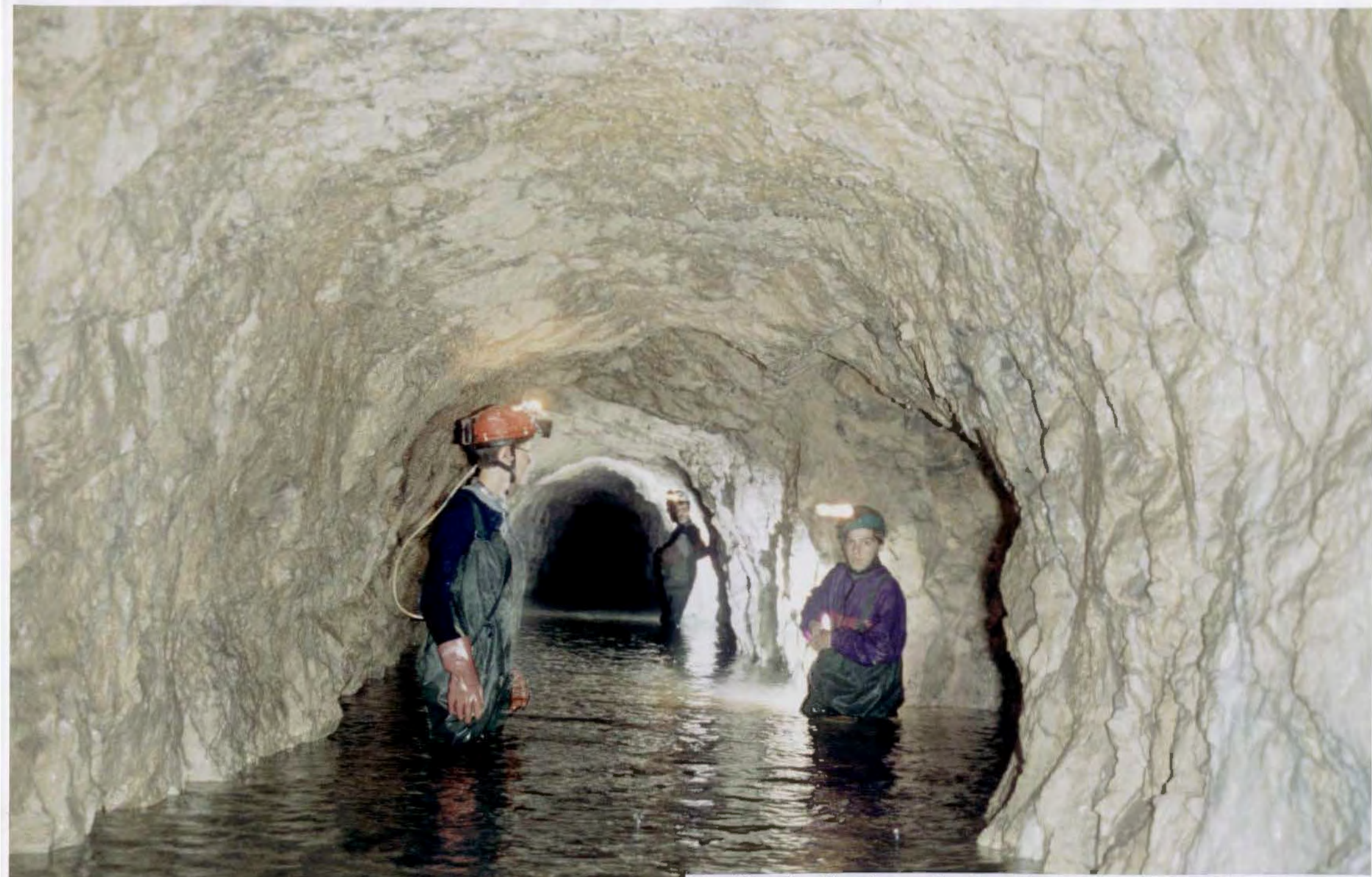
Bauxitbergbau Unterlaussa. Sonnberg-Hauptstollen. Weil das Wasser wegen dem verstürzten Mundloch nicht mehr abfließen kann, ist der Stollen überflutet.
