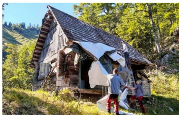
Abtragen der Grünplanhütte
