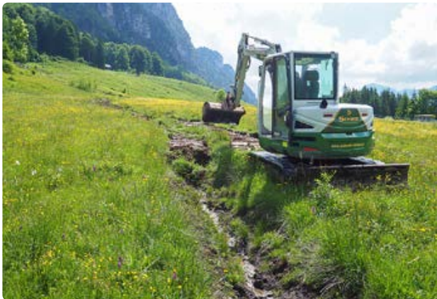
Rückbau getätigter Drainagen in Moorflächen der Puglalm.
