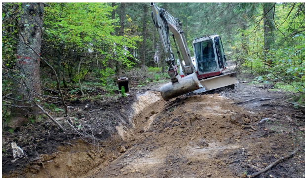
Errichtung eines Ablaufgrabens am Radweg im Bereich kurz vor der Ebenforstalm
