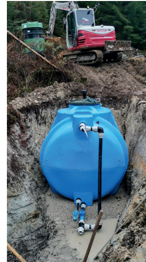
Trinkwasser Hochbehälter mit 5 m³ Fassungsvermögen
