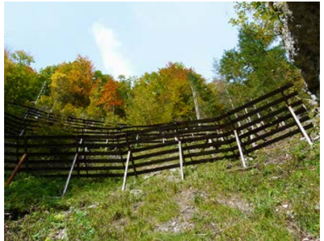
Stahlschneebrücken verhindern das Abreißen von Lawinen.
