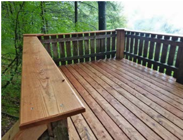
Neuer Boden und Geländer am Aussichtsturm.
