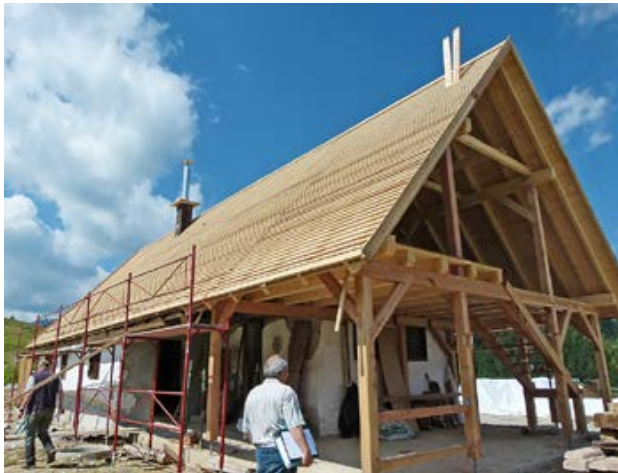
Die Dachkonstruktion wurde komplett erneuert.
