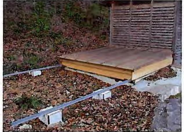
blech ausgewählt. Die ganze Konstruktion ist auf Laufschienen montiert, da zum Wechseln der Toiletteneinheit das Dach zur Seite geschoben werden muss.
