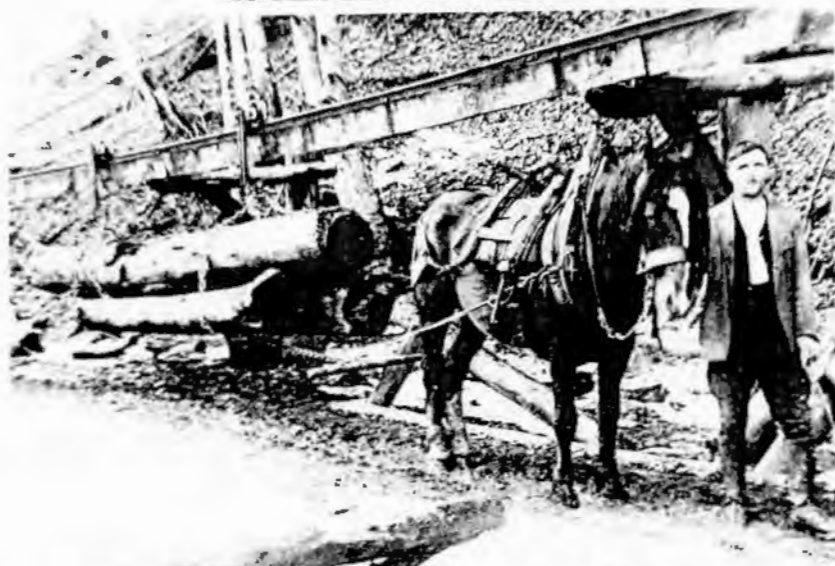
Ein Kuriosum unter den österreichischen Waldbahnen war diese Einschienenhängebahn. Mit ihr gelangten beträchtliche Mengen Holz zur Seilbahnstation Weißwasser.
