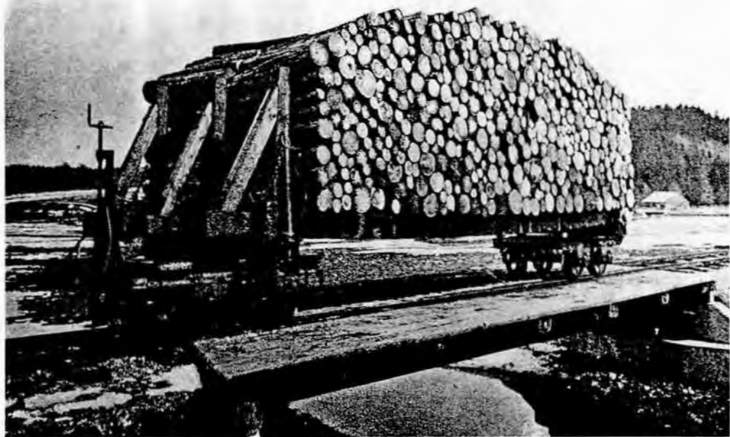
Eine Scheiterkraxe der Kobernauber Waldbahn. Solche Wagengarnituren gelangten als Schwerkraftfahrten nach Schneegattern. Das auf Meterstücke geschnittene Rundholz war für die Zelluloseerzeugung bestimmt. Sammlung M. Feischl (1901/02)
