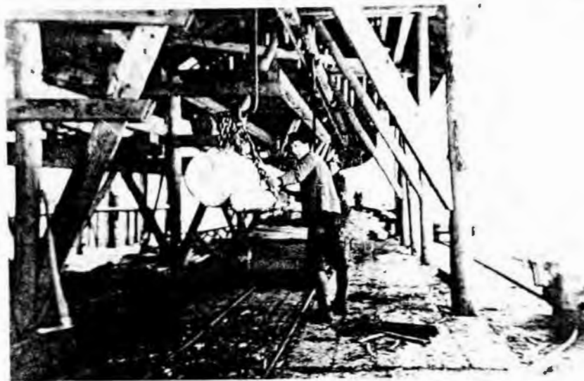
Seilbahnstation Auerhammer. Solche und ähnliche Seilbahnanlagen brachten jahrelang große Holzmengen kostengünstig aus unwegsamen Gebieten.
