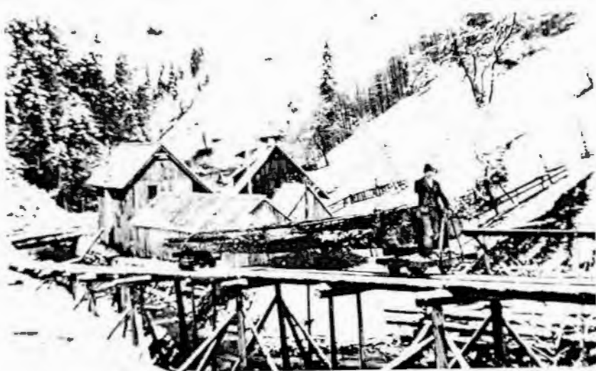
Kurze Zubringerstrecken ermöglichten den Holztransport aus den Seitengraben zu der Seilbahn. Triebfahrzeuge gab es hier nicht; die Leertwagen wurden händisch bewegt und die beladenen Garnituren rollten einfach talwärts.
