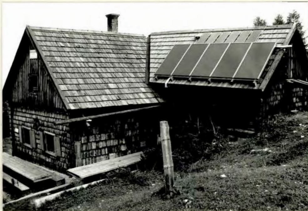
Fertig montierte Photovoltaik- und thermische Solaranlage
