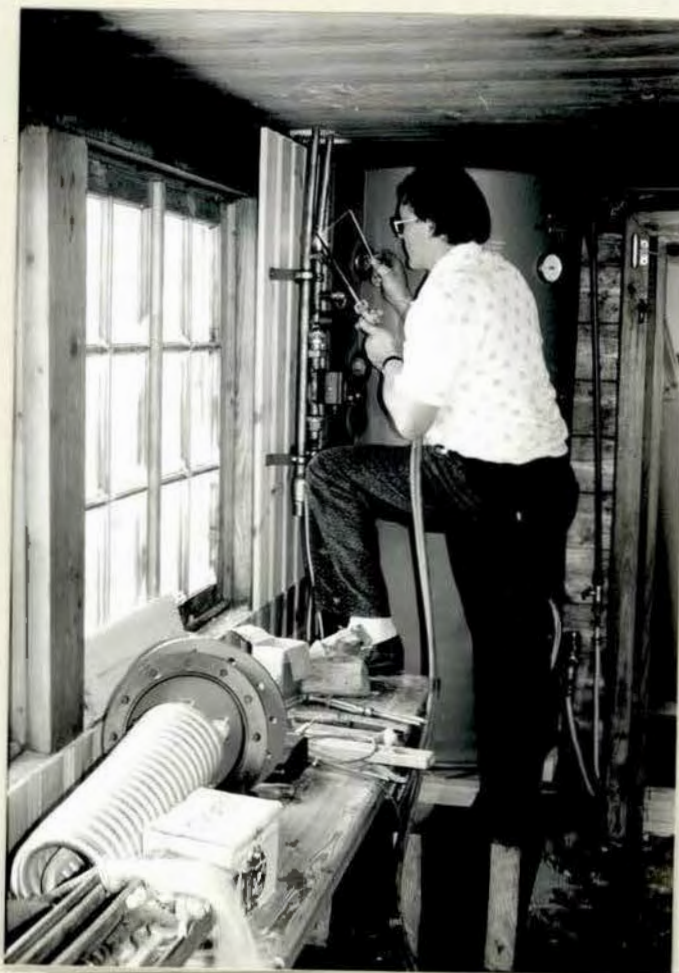
Montage des Boilers (500 l)
