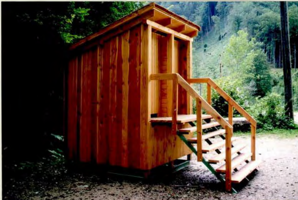
fertig montierter Trockenabort am Reichramingbach
