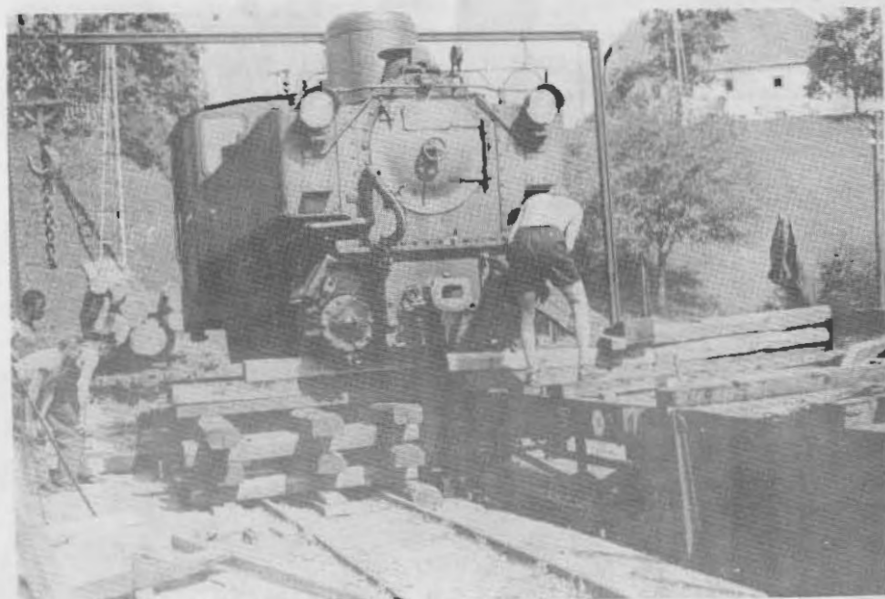
Umladung (Aufpackeln) einer U-Maschine 1941
