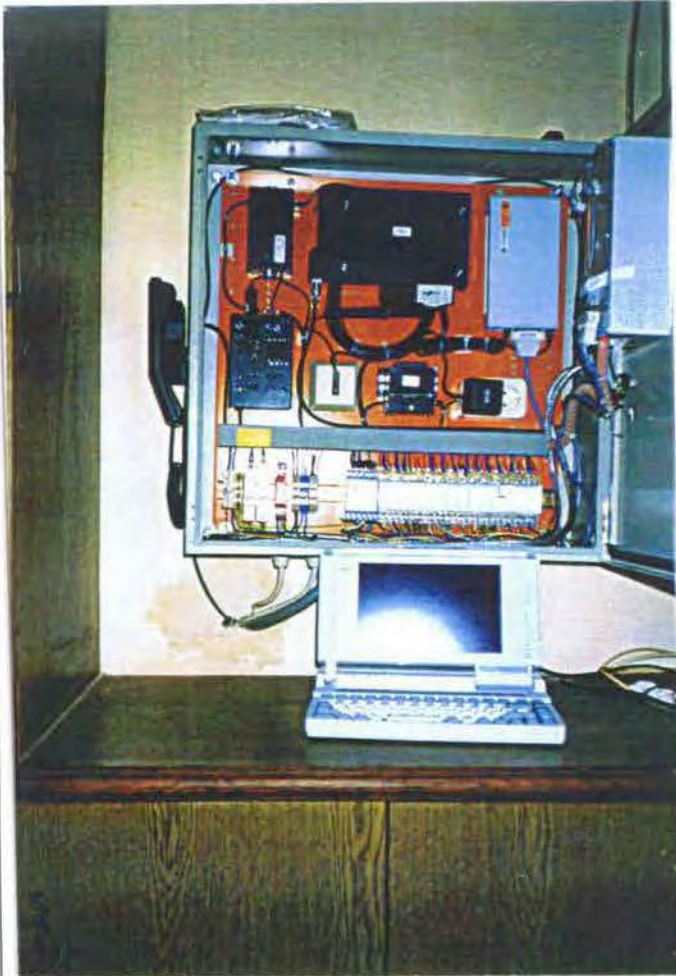
Abb. 5: Meßverteiler Schobersteinhaus mit Datenlogger DRS 16, Modem und D-Netztelefon
