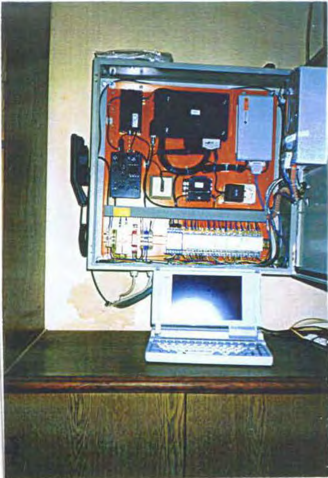
Abb. 5: Meßverteiler Schobersteinhaus mit Datenlogger DRS 16, Modem und D-Netztelefon
