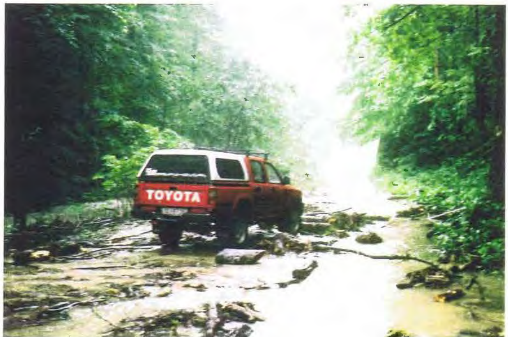
Foto 11: Kurz unterhalb dieser Stelle. Bei HQ30 ufer der Bach massiv aus und zerstört die Straße.
