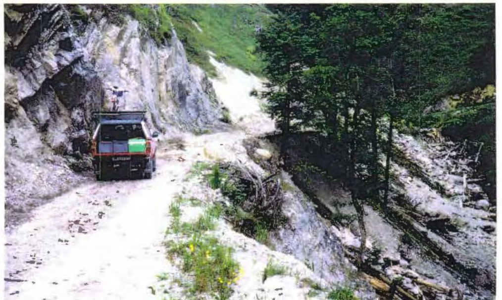
Foto 3: Im Hintergebirge zerstört das Hoch- wasser die meisten Bachquerungen der Forststraßen (hier: Jörglgraben); zum Teil ufern die Bäche über hundert Meter weit aus. Sämtliche Schäden werden aber inner- halb der nächsten zwei Monate wieder saniert.
