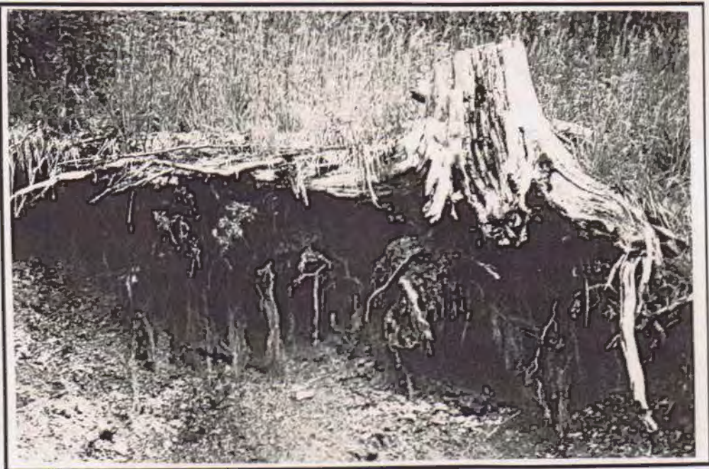
Die Bilder 19-21 zeigen zu wenig ausgerundete Böschungsränder. Diese sind die Ursache für ständiges Hangrieseln und bremsen die natürliche Ansiedelung von Pflanzen.
