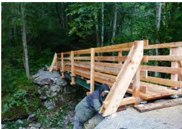
Errichtung der neuen Holzbrücke über den Salzabach.
