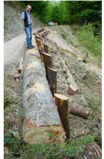
Sanierung der Rutschung auf der Schaumbergalmstraße.
